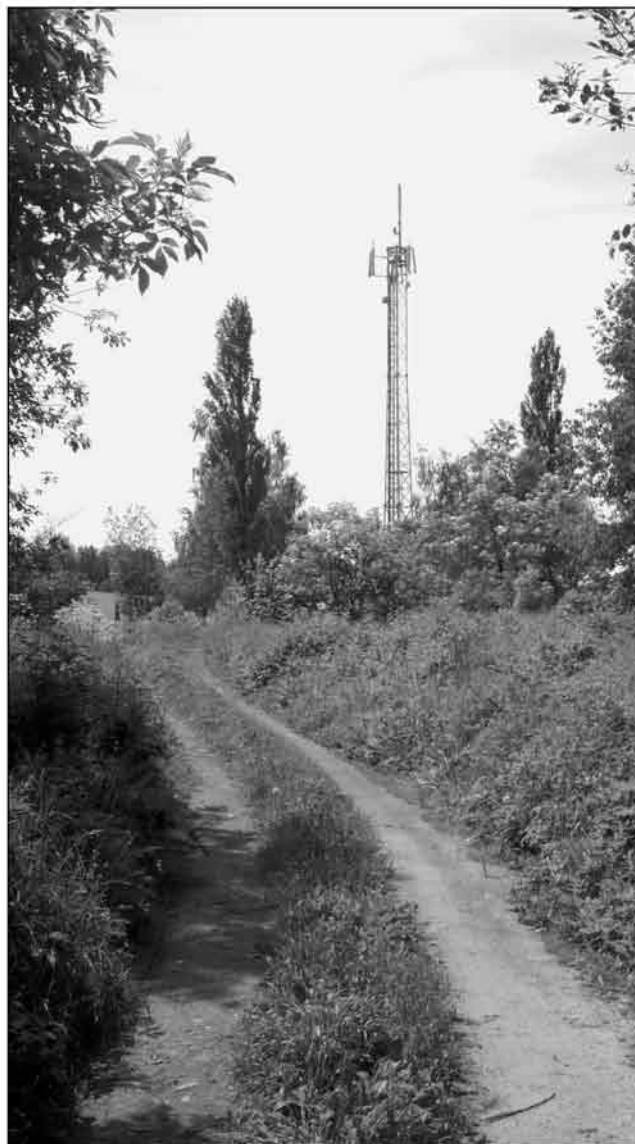
Základnová radiokomunikační stanice (Foto R. Jarošek)
